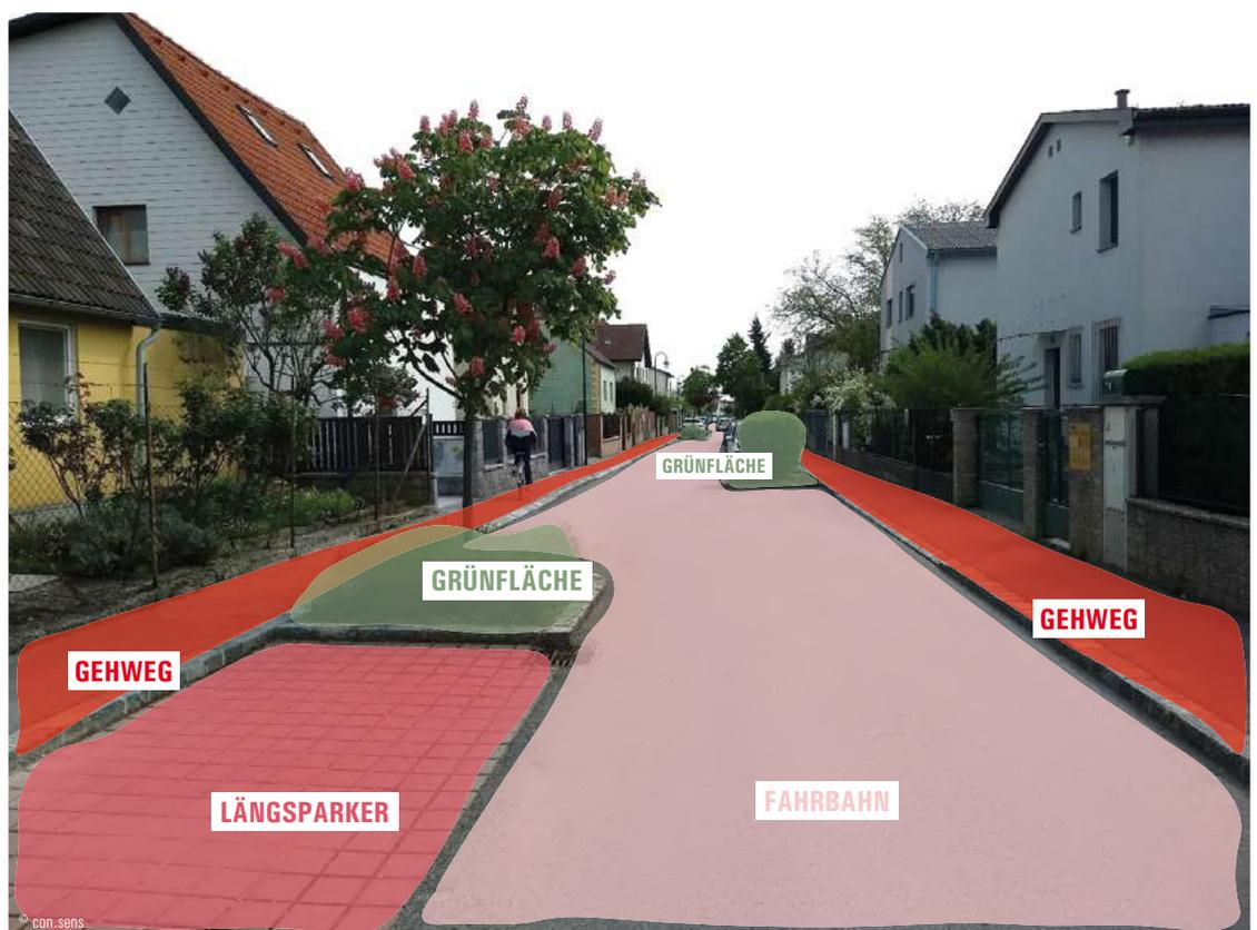
Abbildung 26: Fahrbahnverschwenk mit Gegenverkehrsbereich (Leopoldsdorf, Oberlaaer Straße)
