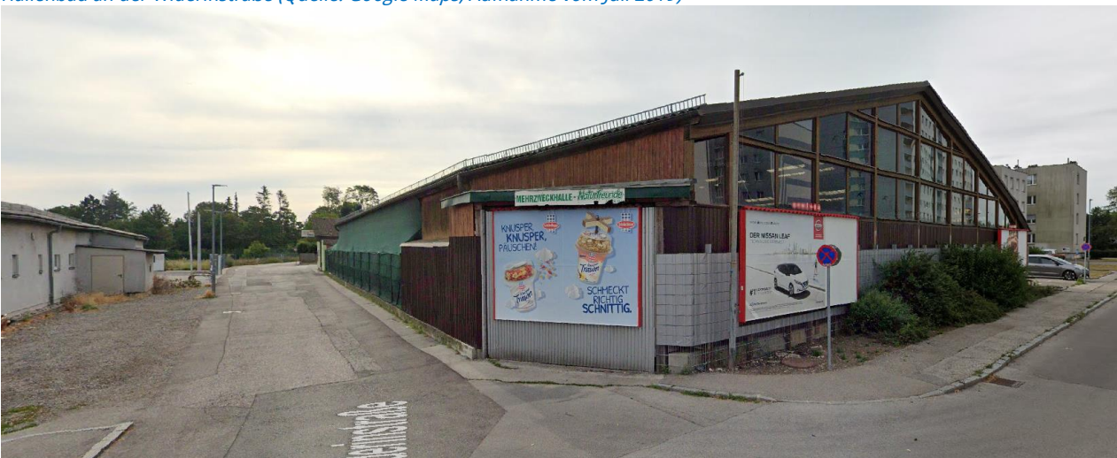
Hallenbau an der Widerinstraße (Quelle: Google Maps, Aufnahme vom Juli 2019)
