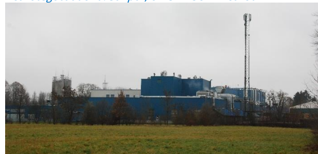
Betriebsgebäude Fa. Sunpor, ein SEVESO-II-Betrieb
