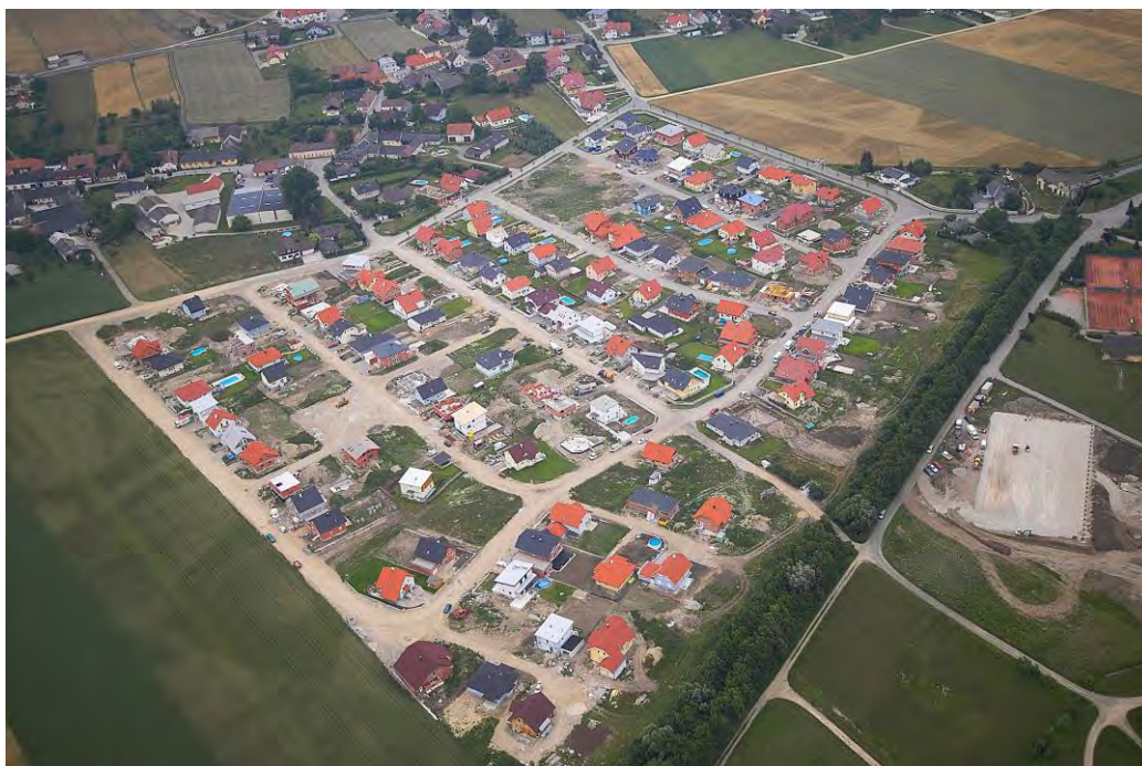
Abbildung 118: Luftaufnahme Baurechtsgründe Ratzersdorf, Quelle: Magistrat der Stadt St. Pölten
