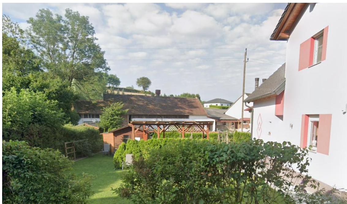
Abbildung 11: Blick auf die 20 kV-Freileitung, südlich der Tannengasse, Quelle: Google StreetView
