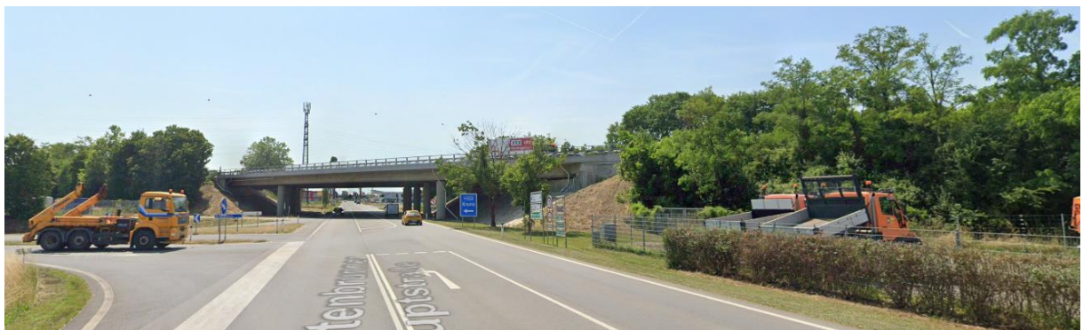
Abbildung 4: Trasse der S33 inklusive Böschungsbegrünung bei der Auffahrt St. Pölten Nord südlich der Straßenmeisterei, Blickrichtung Südwesten (Quelle: Google Street View).
