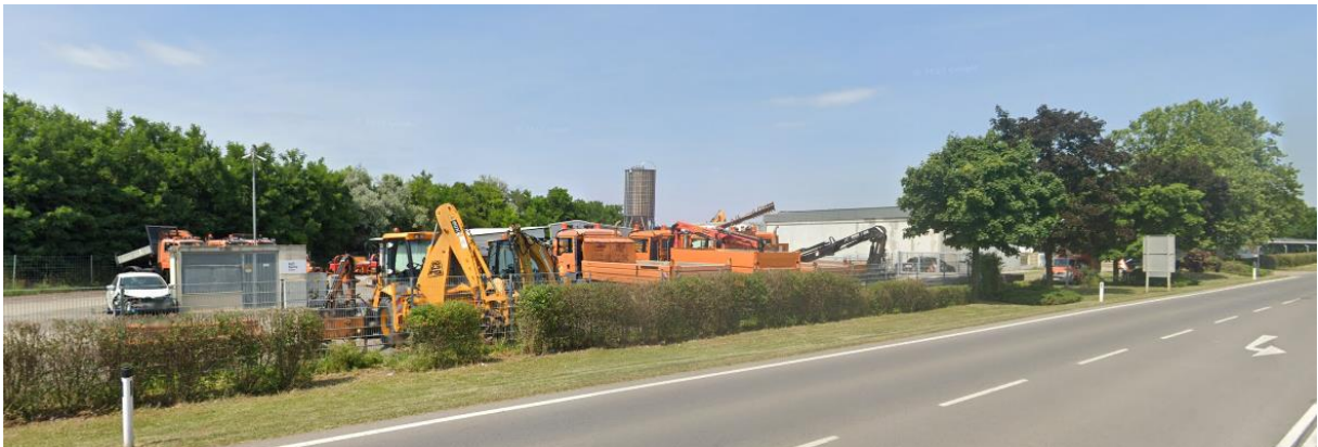
Abbildung 6: Ansicht auf das Gelände der Straßenmeisterei westlich des WSZ, Blickrichtung Nordosten (Quelle: Google Street View).
