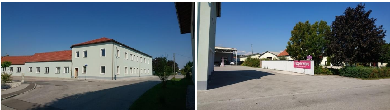
Betriebs- und Wohnhaus für die Fa. FreFa, Tupperware, Depot des Landestheaters
