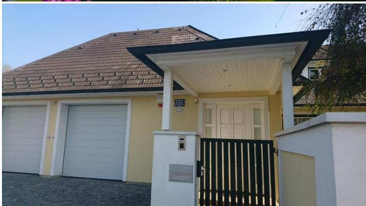
Einfamilienhäuser mit schönen Vorgärten und Eingangsbereichen, entlang der Ratzersdorfer Haupt- straße 120 und 122
