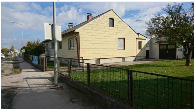
Entlang der Ratzersdorfer Hauptstraße: Eingeschossige, kleinvolumige Baukörper mit Satteldächern und teilweise ausgebauten Dachgeschossen
