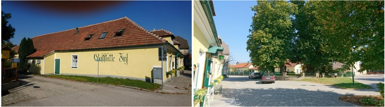
Das Gasthaus Figl ergibt gemeinsam mit dem Hauptplatz ein prägendes Ensemble im Zentrum von Ratzersdorf
