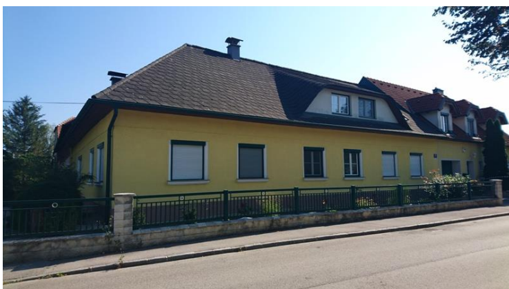
Buchbergerstraße 10 bis 14: Ein- und zweigeschossige Einfamilienhäuser mit Nebengebäuden, als Garagen verwendet
