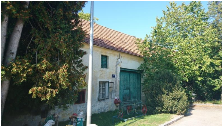
Buchbergerstraße 19: Erhaltenswürdiges landwirtschaftliches Objekt, derzeit leer stehend.
