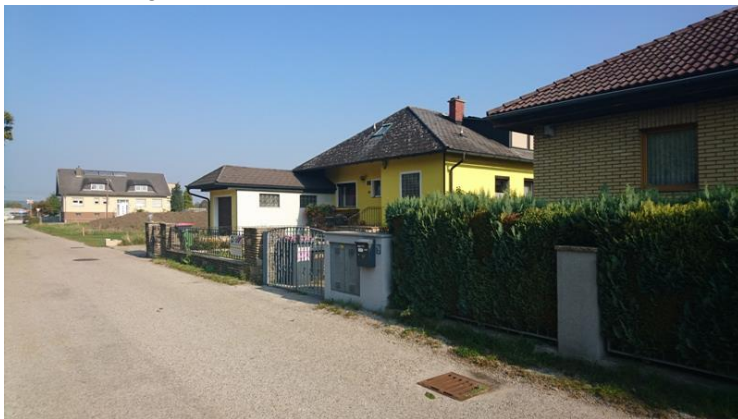
Bestehende Einfamilienhäuser in der Gerichtsfeldgasse
