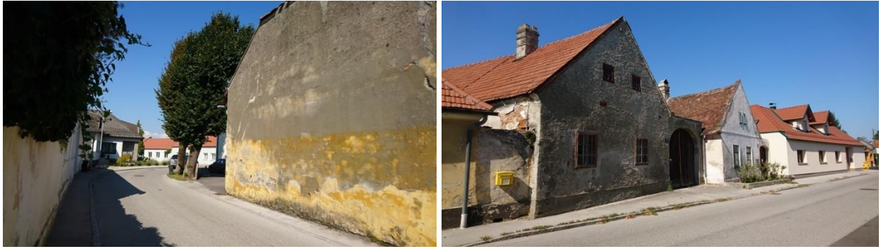
Sanierungs- bzw. renovierungsbedürftige historische Bauernhäuser
