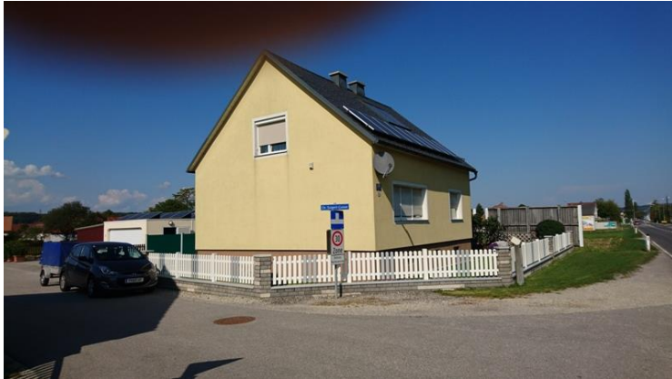
Wohnhaus mit Garage im Hintergrund, im Kreuzungsbereich Ratzersorfer Hauptstraße und Dr. Szigeti-Gasse
