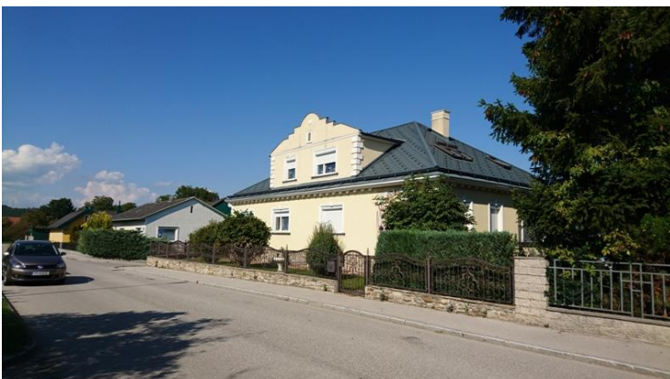
Wohnhaus mit reichhaltig gestaltetem Erker – Buchbergerstraße 83 / Ecke Seewiesengasse
