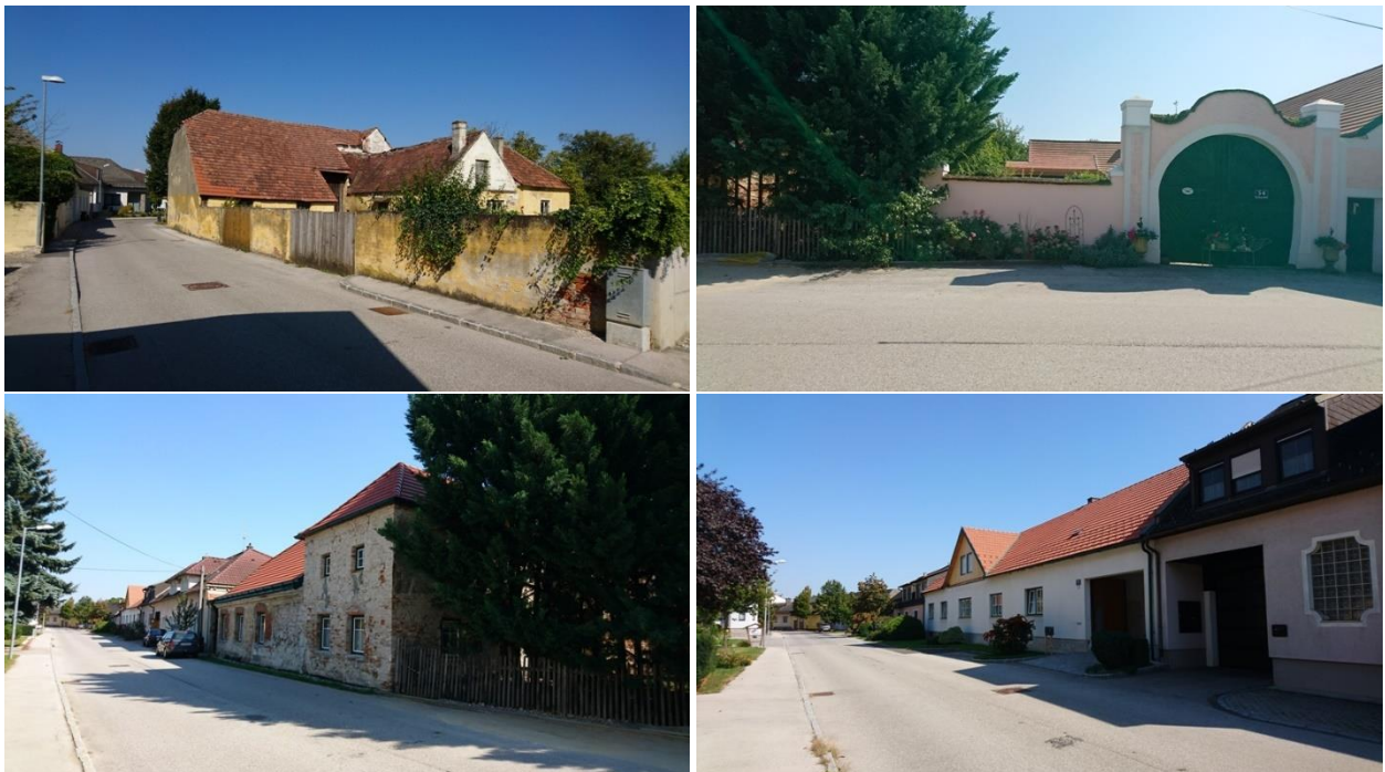
Historisch gewachsene Bebauungsstruktur in geschlossener Bauweise
