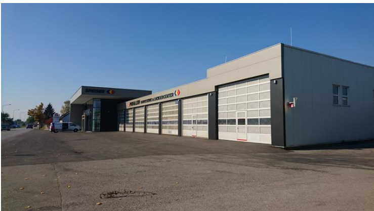
Zwischen der Betriebsanlage der Fa. Speiser und der Buchbergerstraße sind drei zweigeschossige Einfamilienhäuser Ratzersdorfer Hauptstraße 41, 43 und 45
