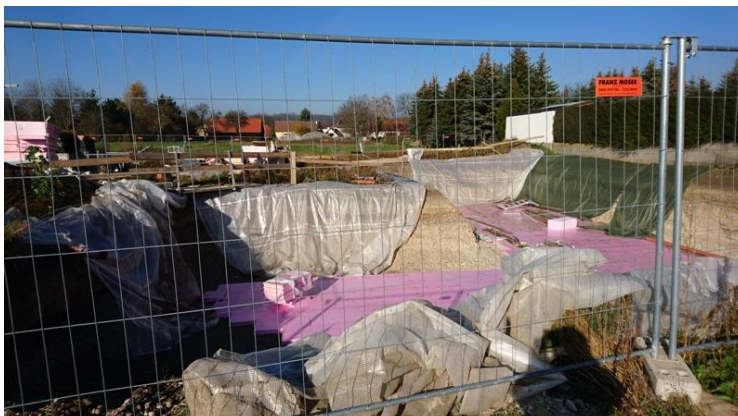
Baugrubenaushub in dieser schmalen, namenlosen Straße
