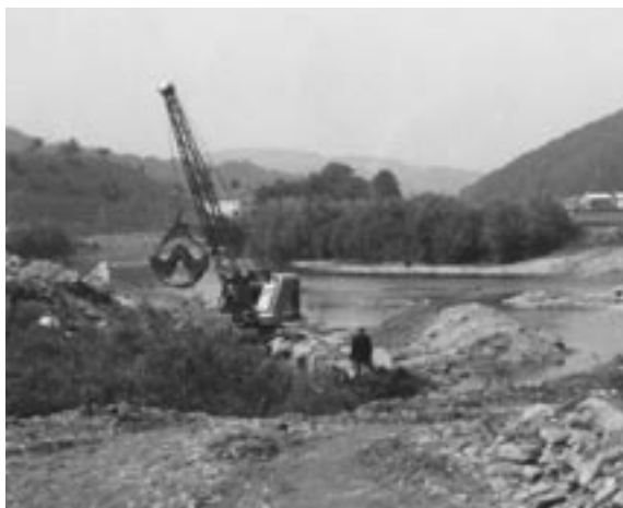
Einsatz des Löffelbaggers bei der Traisenregulierung im Jahr 1966
