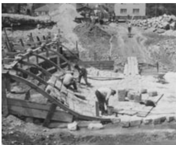
Die Bilder zeigen die Sinoidalschwelle in der Gemeinde Traisen während (links) und nach der Errichtung (rechts).
