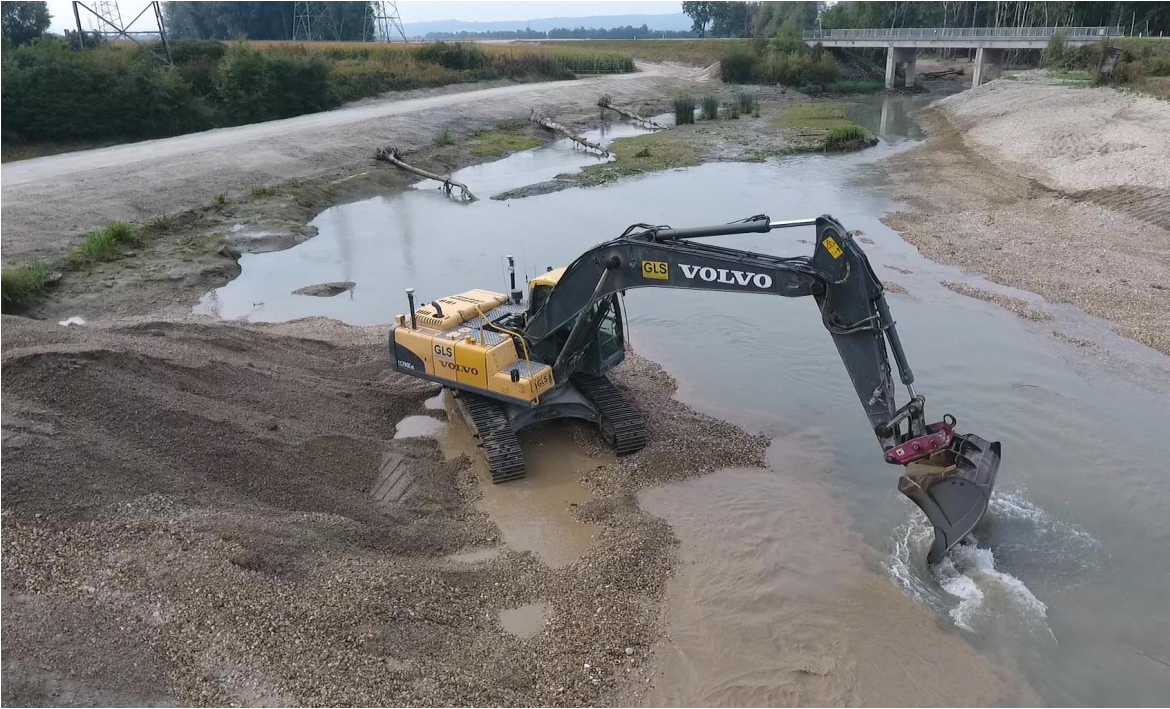
Im Rahmen des LIFE-Projekts wurden die Flussbett- und Uferstrukturen der unteren Traisen naturnah gestaltet.
