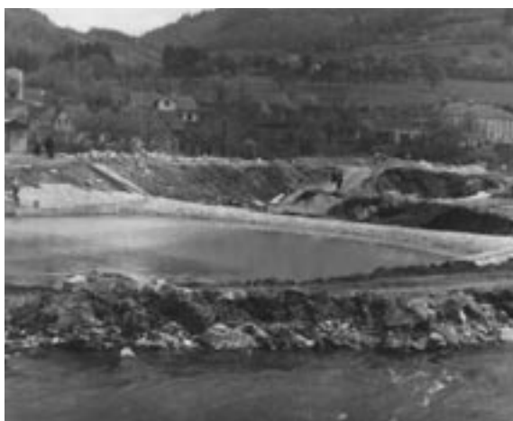
Die Regulierungsmaßnahmen in der Gemeinde Traisen erfolgten zwischen 1966 und 1973 (Bild links und rechts).
