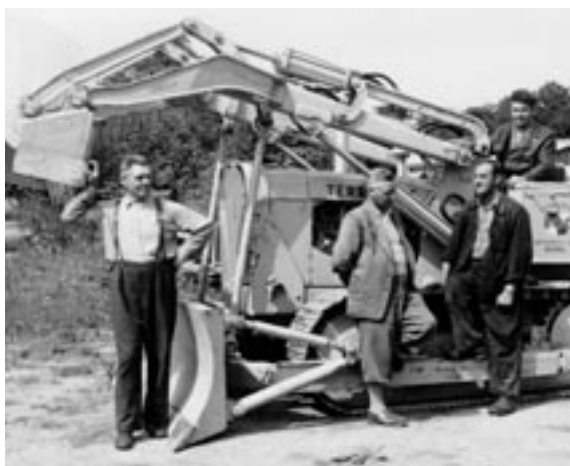
Ankauf einer Laderaupe durch den Wasserverband im Jahr 1958
