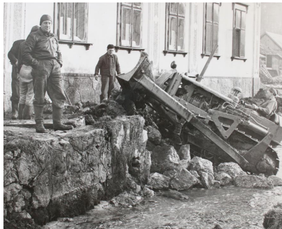
Der Einsatz von Maschinen erleichterte die Arbeiten erheblich. Das Bild zeigt eine Schubraupe bei den Regulierungsarbeiten an der oberen Traisen.
