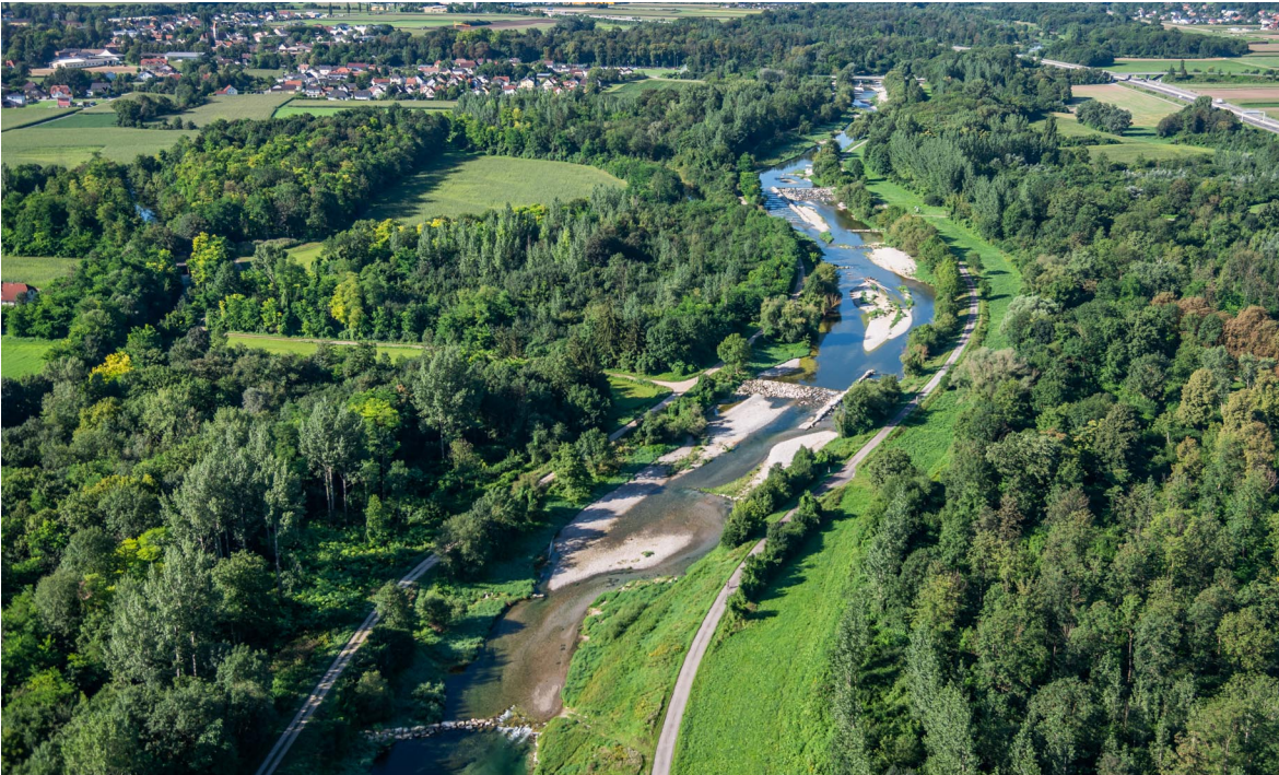
Im Rahmen des wasserwirtschaftlichen Versuchs wurden im Bereich von Pottenbrunn zahlreiche Migrationshindernisse beseitigt und das Gerinne nach gewässerökologischen Gesichtspunkten gestaltet.
