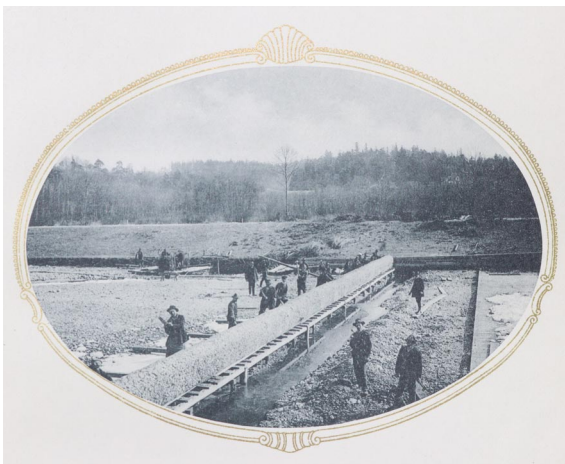
Herstellung einer Steinsenkwälze als Sohlenschutz in Ochsenburg
