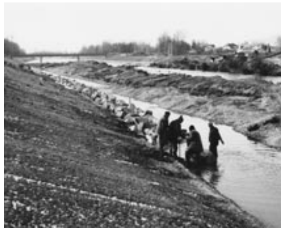
Bei der Regulierung der Traisen in Traismauer zwischen 1965 und 1969 wurden große Erdmassen bewegt (Bild links). Den Böschungsfuß sicherten die Wasserbauer mit einem Blockwurf (Bild rechts).
