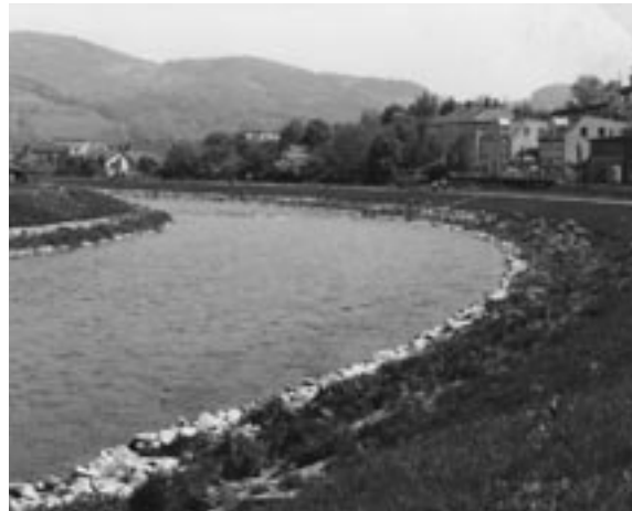
Das Gerinne der Traisen wurde gestreckt und mit einer monotonen Böschung ausgestaltet. Die Bilder zeigen den Fluss in der Gemeinde Traisen vor (links) und nach der Begrünung (rechts).
