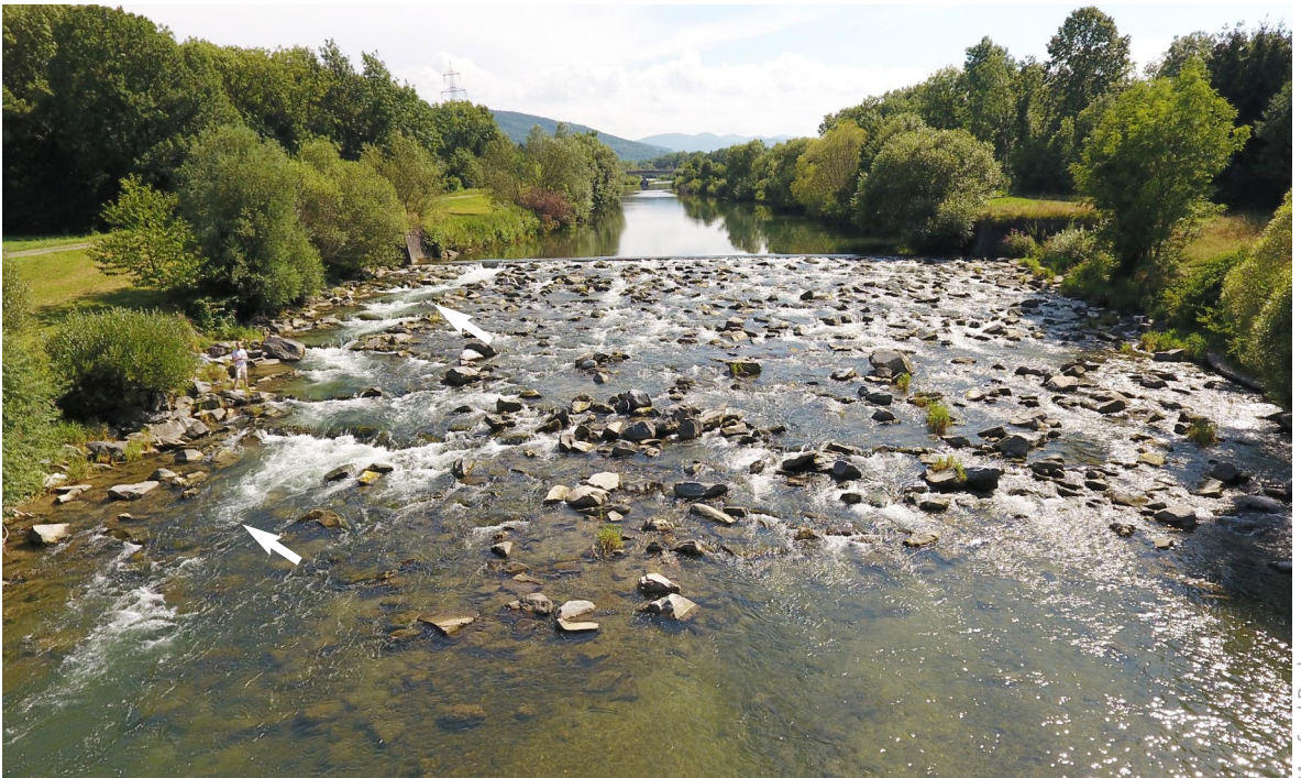
Bei der Rampe in Ochsenburg wurde eine für Fische passierbare Rinne (links im Bild) geschaffen.
