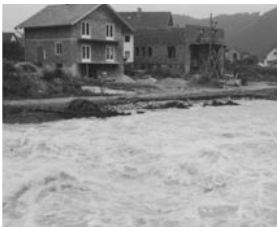
Das Hochwasser 1966 führte in Türrnitz (Bild links) und Traisen (Bild rechts) zu größeren Ausuferungen.
