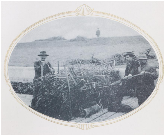
Durch eine innovative Maschine für die Herstellung der Senkstücke konnte die Effizienz der Wasserbauarbeiten wesentlich erhöht werden.
