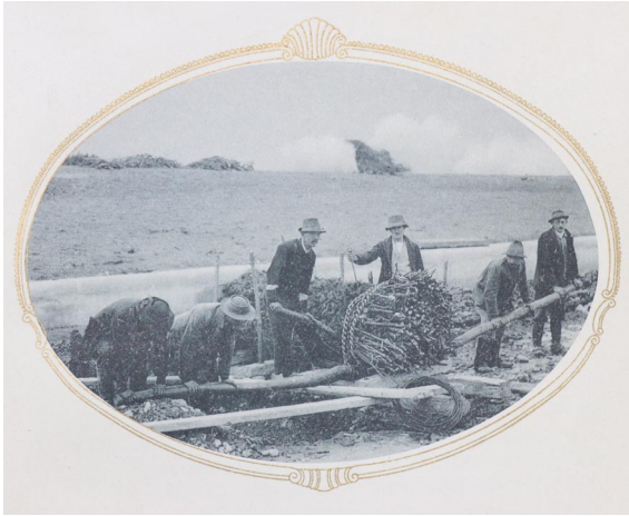
Händische Vorbereitung der Senkstücke für den Einbau bei Altmannsdorf
