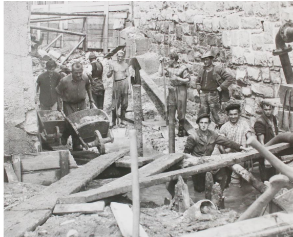
Der Wasserbau war lange Zeit sehr arbeitsintensiv.
